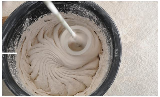
2. Après le gâchage, étendre sur les pièces à coller de façon à ce que la couche ne soit pas trop épaisse.
